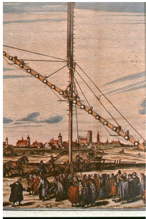
Vor den Toren von Danzig Riesenfernrohr mit einer Tubuslänge von 50 m
